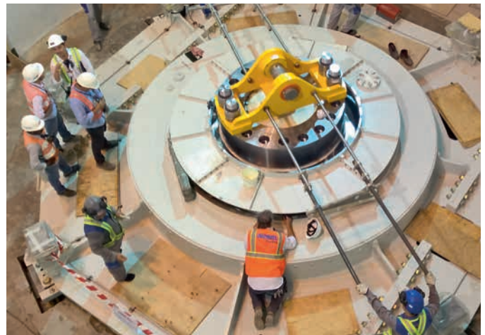
Lowering rotor unit #1 HPPLaúca
