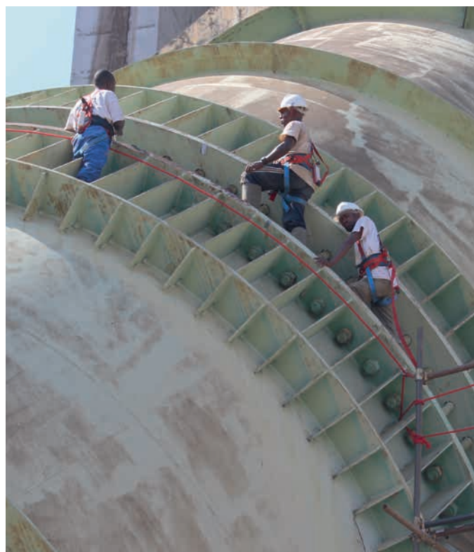
Penstock HPP Inga 2
